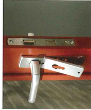
Het ombuigen van de afdekplaat waardoor de cilinder wordt "gebroken"
